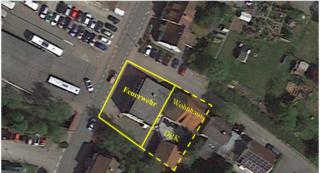
Luftbild – Feuerwehrhaus Zaberfeld
